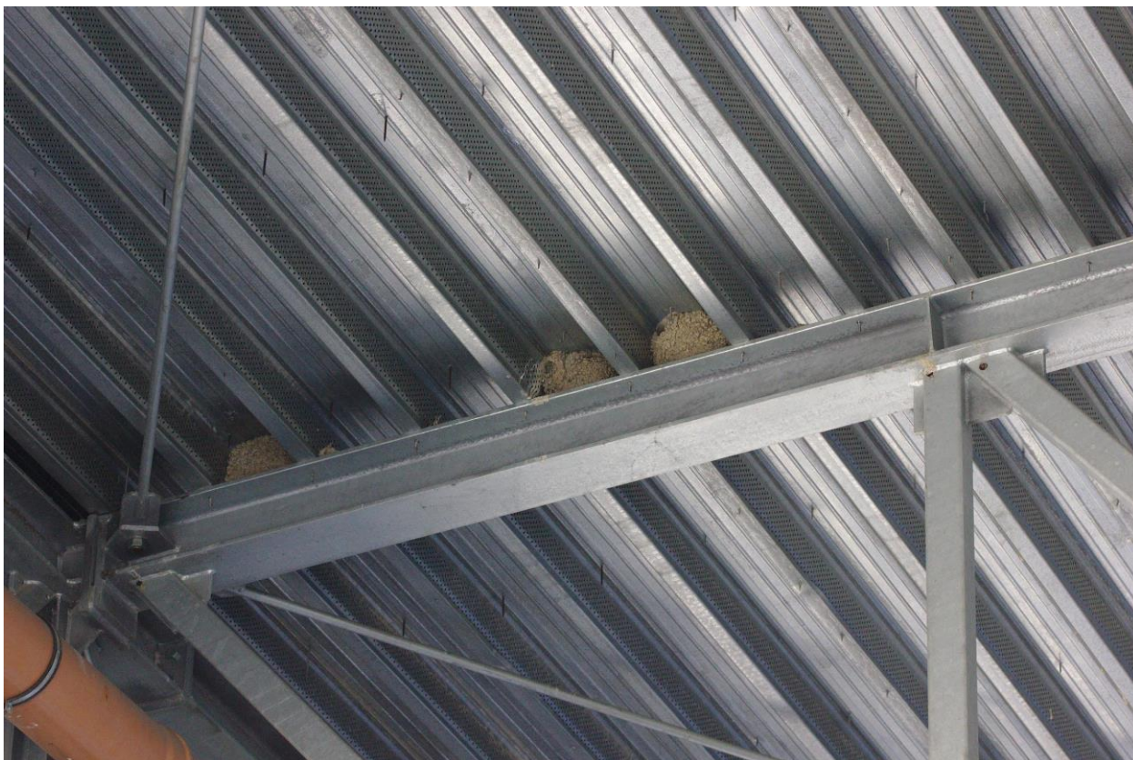
Rysunek nr 18. Gniazda oknówek pod dachem przy pobliskiej hali.
