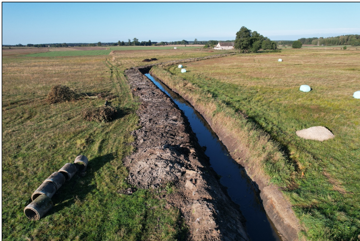
Fotografia 3 Odcinek cieku Bukówka przecinający teren planowanego przedsięwzięcia będący w trakcie prac melioracyjnych (fot. M. Roszyk)
