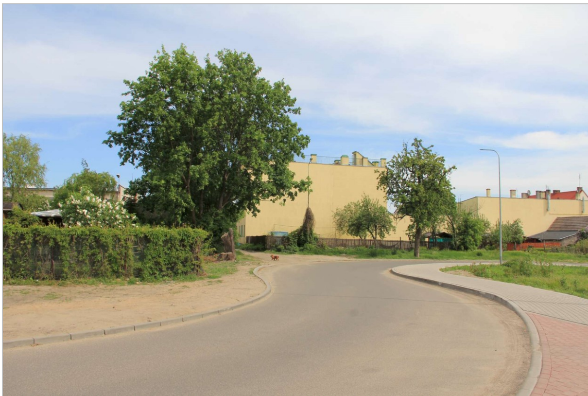
Nowa nawierzchnia na ul. Krętej w Trzciance
