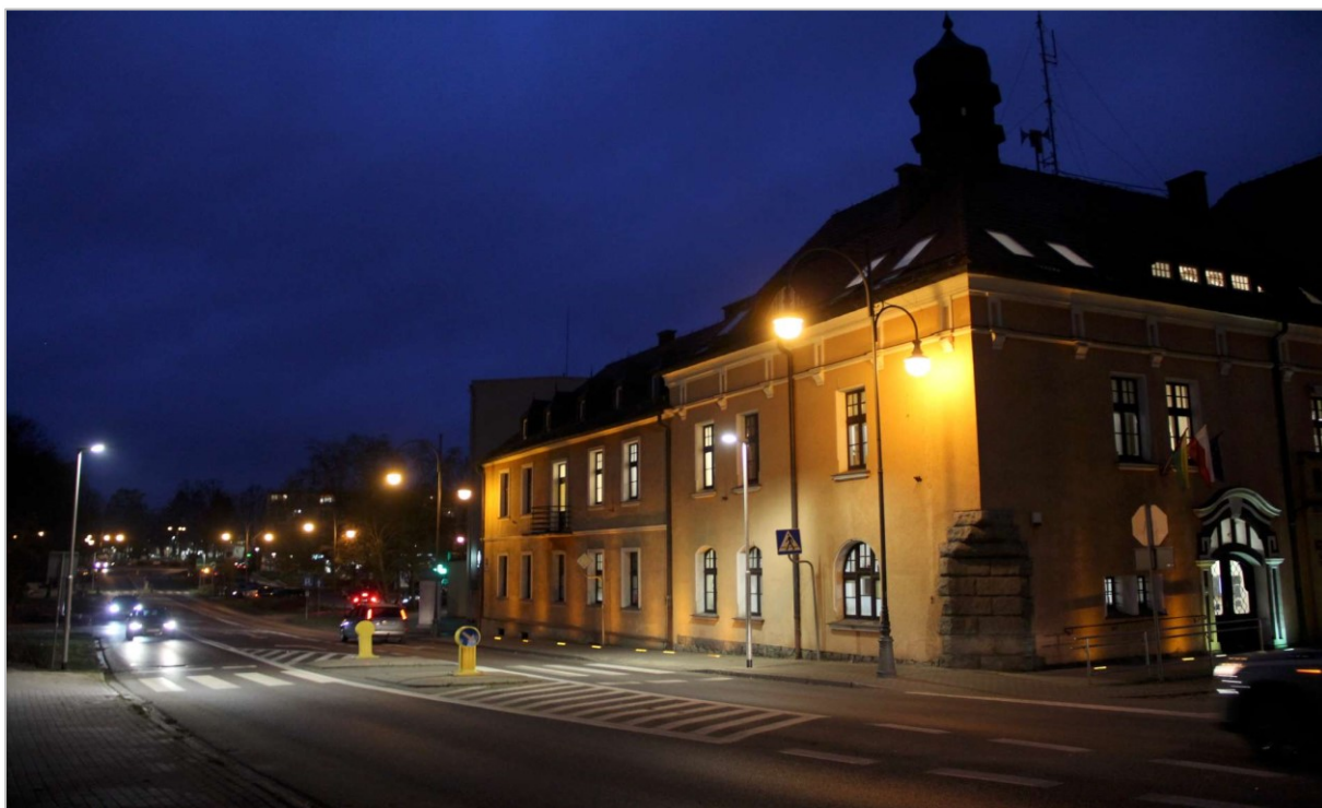
Oświetlenie przejścia dla pieszych przy ul. Sikorskiego
