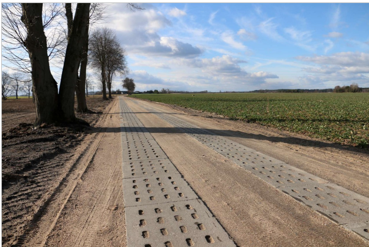
Droga dojazdowa do gruntów rolnych w Rudce
