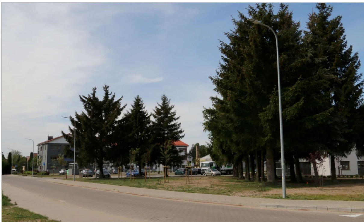
Oświetlenie ul. Fabrycznej w Trzciance
