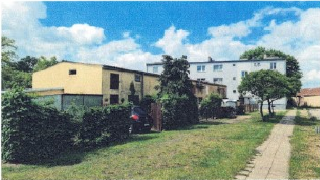
Zdjęcie 18. Biała - widok od strony ul. Górne Podwórze
