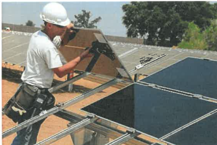
Fot. 3 Montaż modułów na stelażach – przykład
