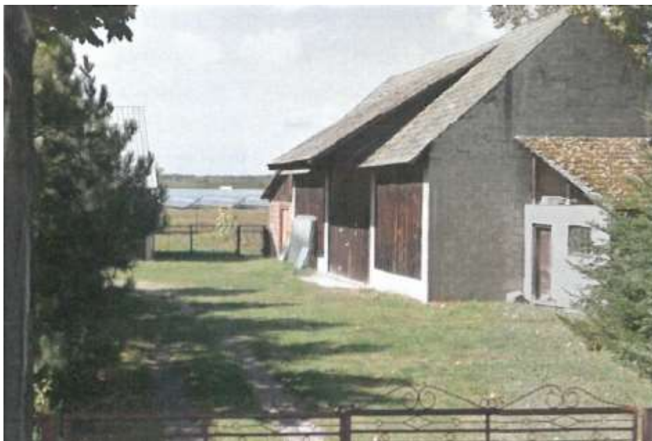
Zdjęcie 14 Widok na instalację fotowoltaiczną z odległości ok. 140 m.
