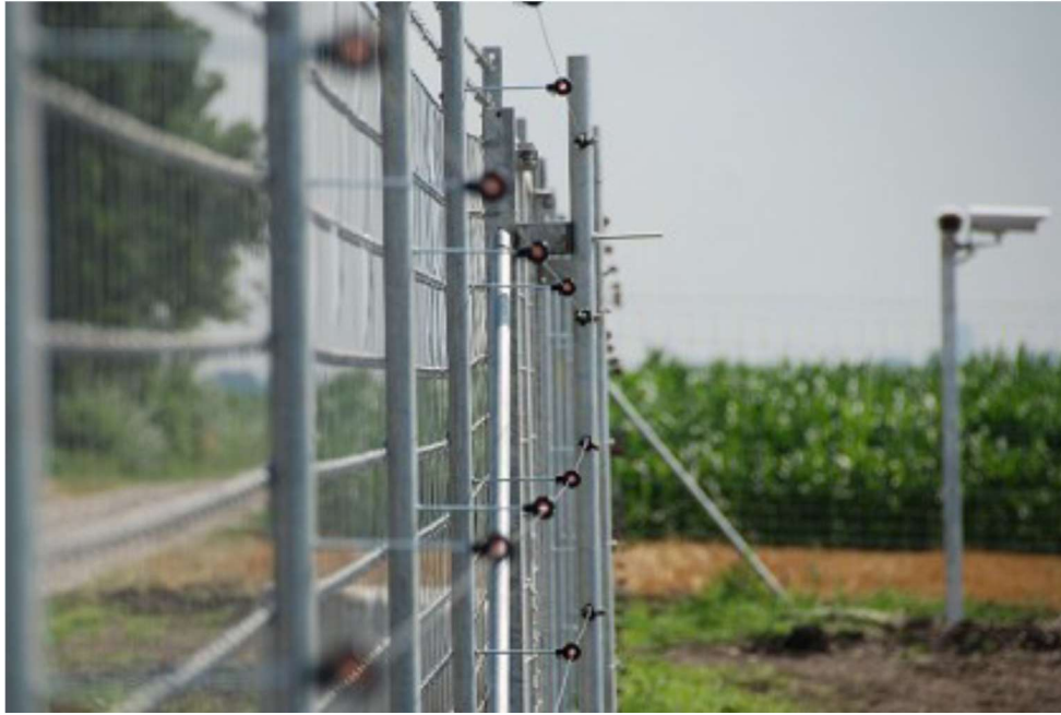
Zdjęcie 11 Przykładowe ogrodzenie elektrowni fotowoltaicznej.
