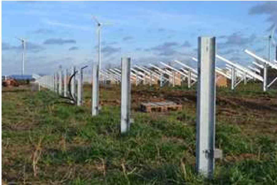
Zdjęcie 4 Profile metalowe: podstawowy element konstrukcji.
