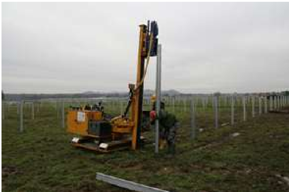
Zdjęcie 5 Montaż profili za pomocą kafara.
