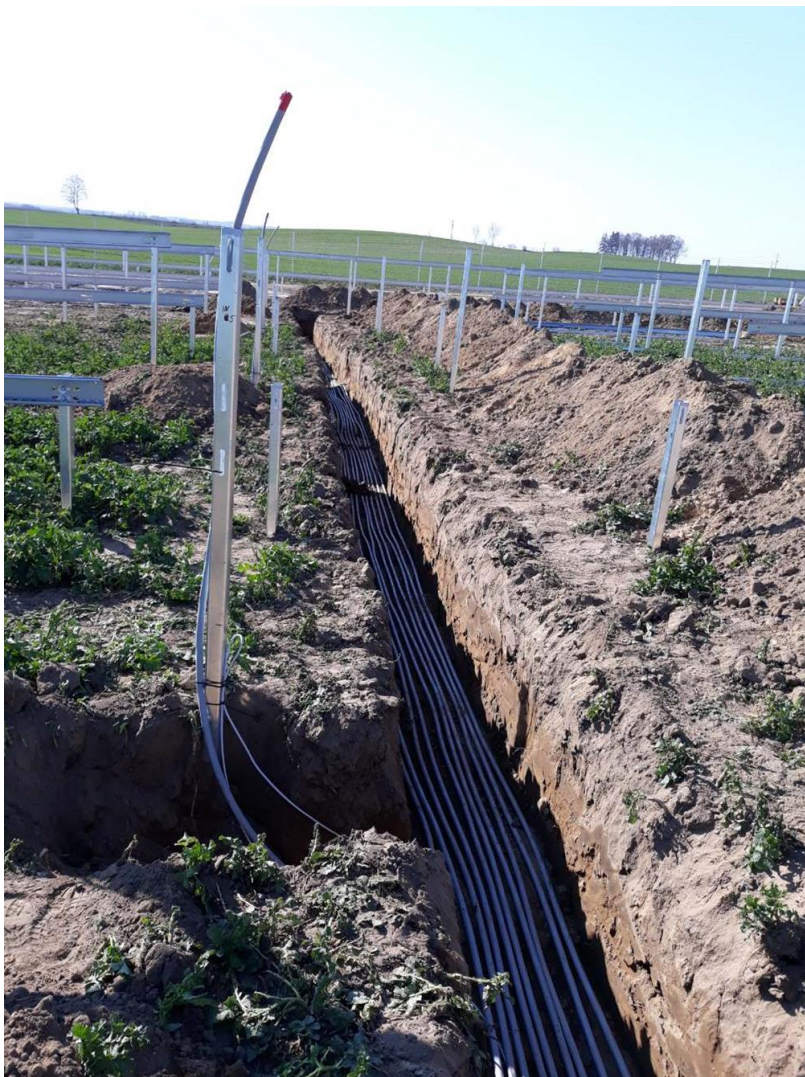
Rysunek 24 Przewody ułożone w wykopie
