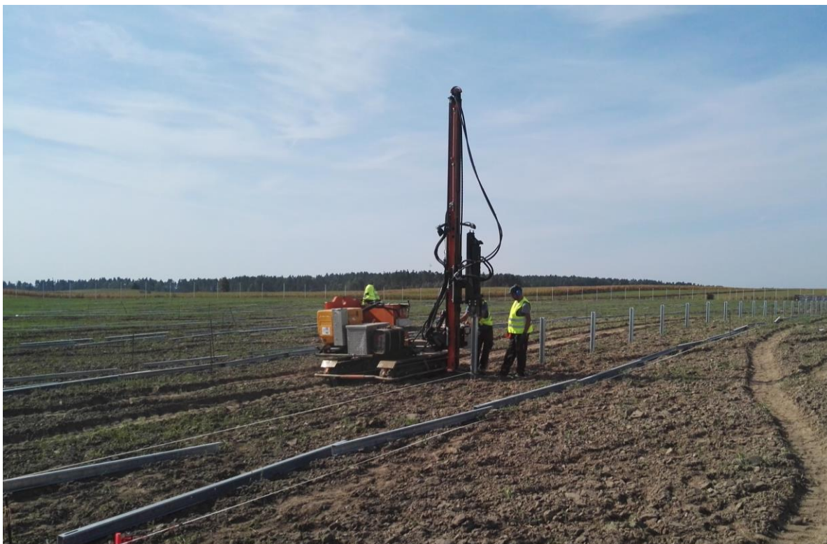
Rysunek 23 Katar do wbijania profili nośnych
