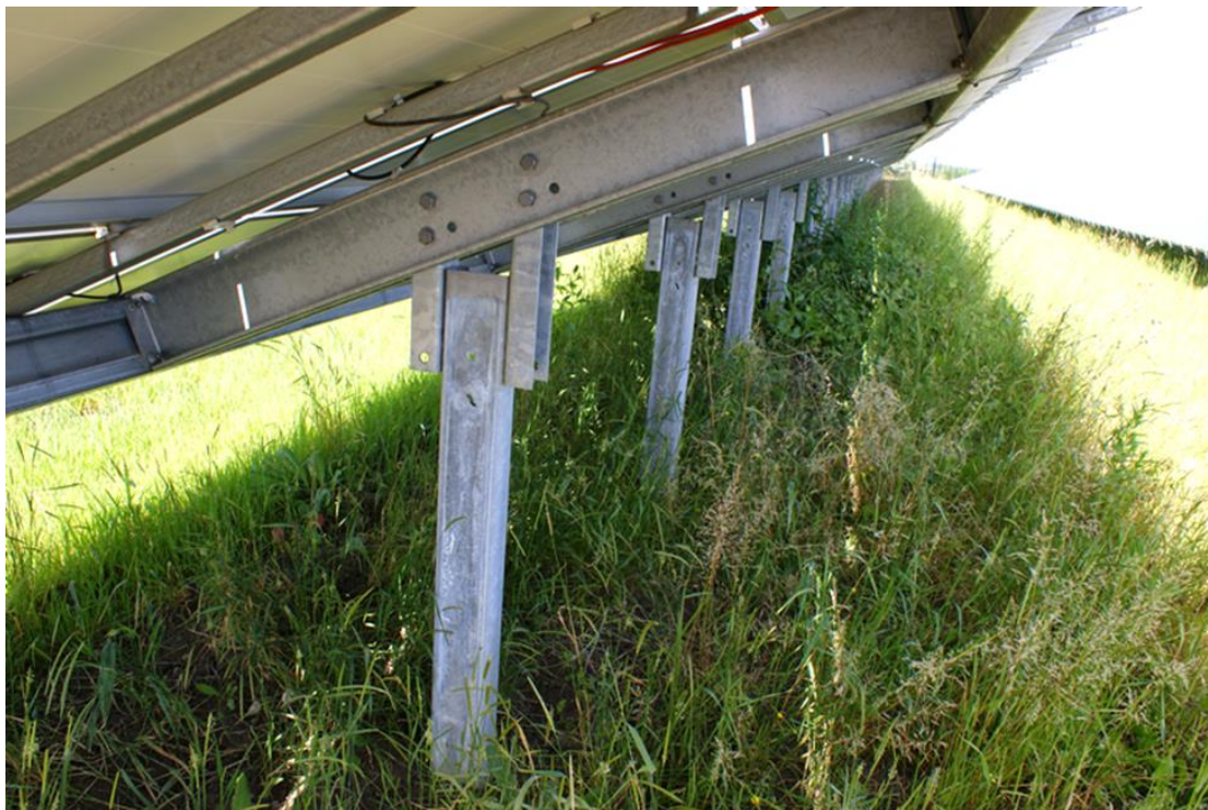
Rysunek 14 Sposób łączenia szkieletu-podstawy modułów fotowoltaicznych z profilami bez zastrzałów
