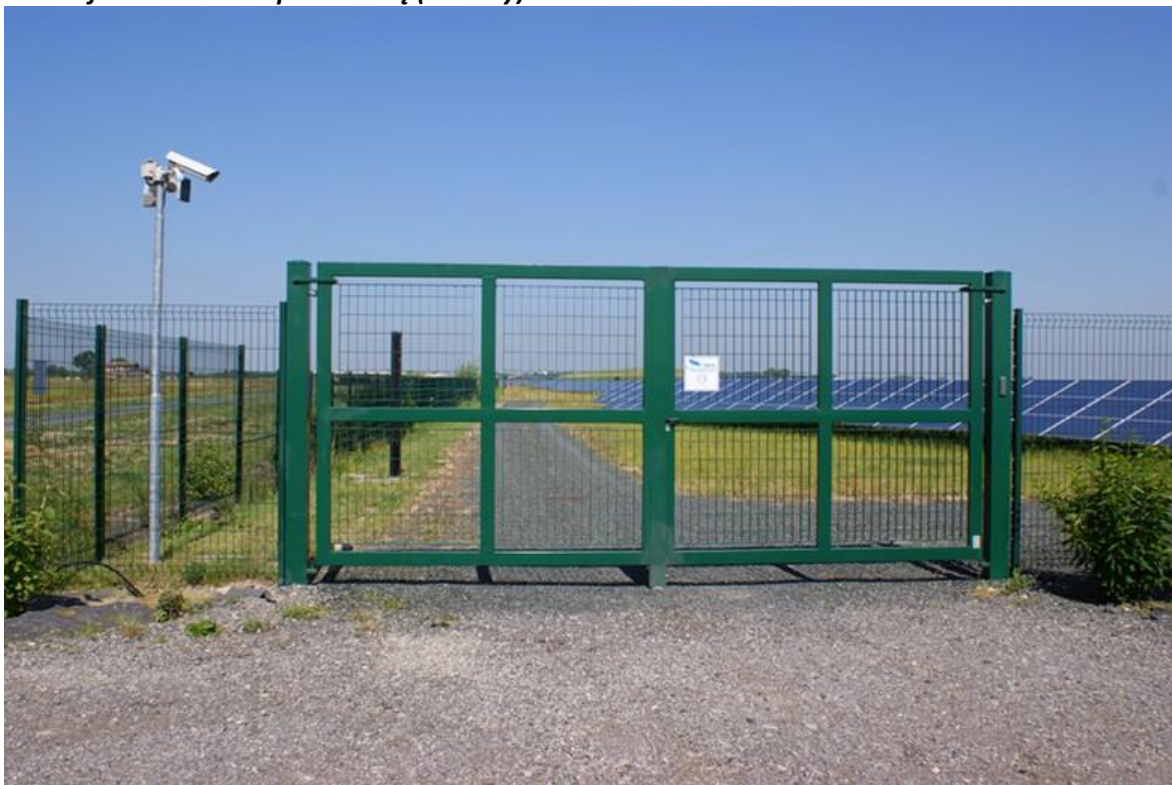
Rysunek 21 Brama wjazdowa oraz system monitoringu
