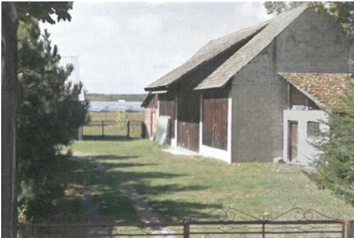
Rysunek 21 widok na instalację fotowoltaiczną z odległości ok. 140 m.
