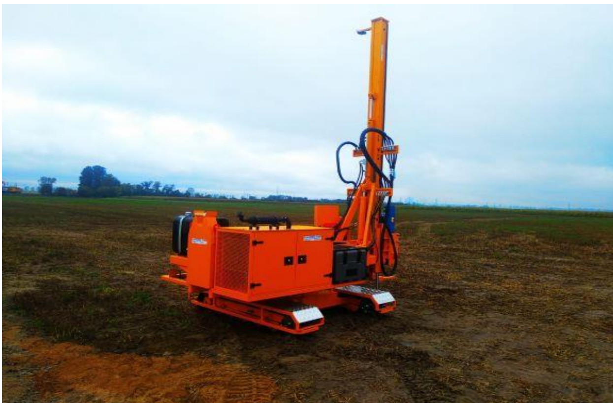
Rycina 4. Budowa konstrukcji za pomocą kafara.
