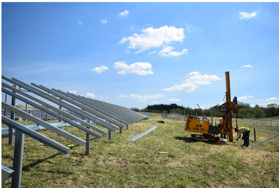
Zdjęcie 5. Prace budowlane przy realizacji farmy fotowoltaicznej PV Lesko dla PGE Energia Odnawialna S.A.
