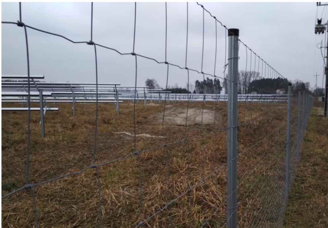
FOTOGRAFIA 6. Widok na przykładowe ogrodzenie dla instalacji, o ustalonej szerokości oczek w siatce [foto: Paweł Kręciproch; instalacja w miejscowości Poddębice]
