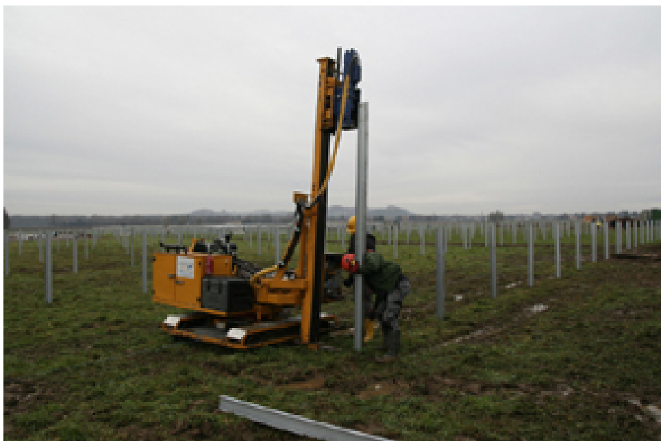
Zdjęcie 2 Montaż profili za pomocą kafara.
