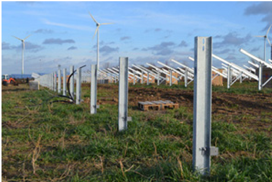
Zdjęcie 1 Profile metalowe: podstawowy element konstrukcji.
