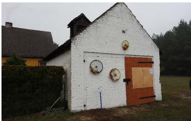
Zdjęcie nr 12 – Budynek gospodarczy
